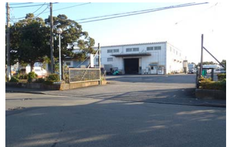
写真3 若葉運輸側入口
